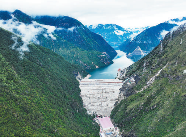
双江口水电站。
